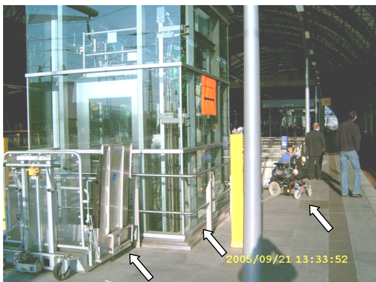
Рисунок 2.3. Подъемник и лифт для инвалидов на главном вокзале в г. Дрездене, 2005 г.
