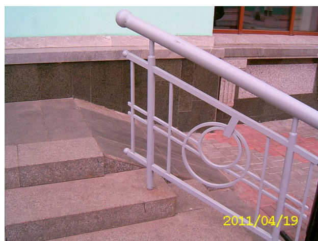
Рисунок 3.20. Пандус, ведущий на перрон недоступен для инвалидов
