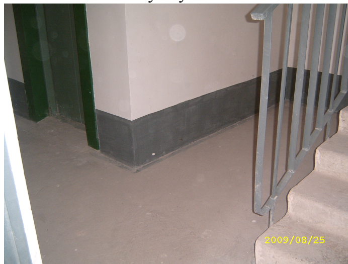
Рисунок 1.2. Лифт проходного типа в новостройках г. Омска 2009 г.
