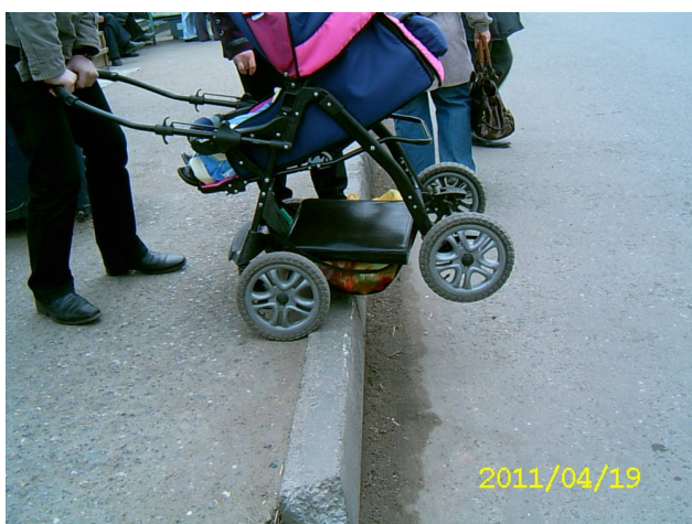
Рисунок 3.14. На посадочных площадках остановок не обеспечены пути передвижения маломобильных граждан
