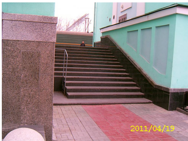
Рисунок 3.21 Лестницы, ведущие на перрон недоступны для инвалидов-колясочников
