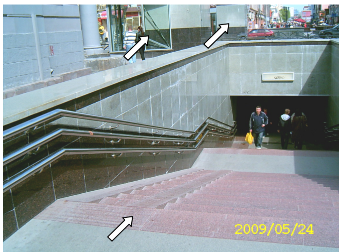
Рисунок 1.3. В Екатеринбурге строят пешеходные переходы с пандусами и лифтами для МГН, 2009 г.
