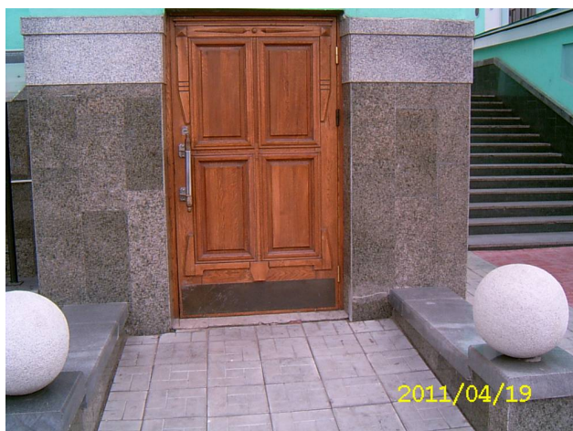
Рисунок 3.22. Дверь, за которой скрыт неработающий лифт для инвалидов
