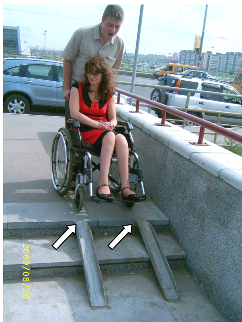
Рисунок 3.6. Такая конструкция не обеспечивает доступность объекта для МГН, г. Омск, 2009 г.
