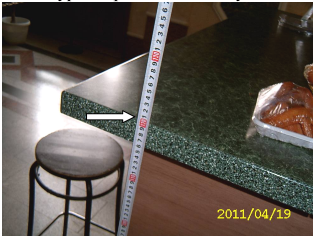
Рисунок 3.17. Высота торговой плоскости буфета составляет 120 см (норма 80 см)
