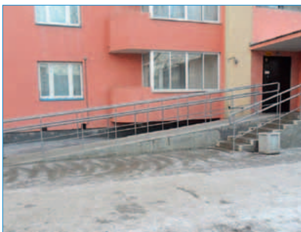
Рис. 10. Пандус с уклоном 1:8, поручни двухуровневые, закругленные, выступают на 0,3 м
