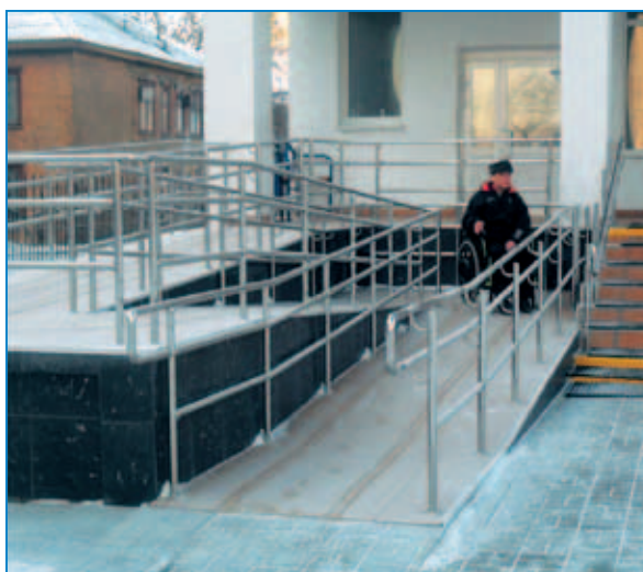
Рис. 12. Пандус с площадками для разворота. Правильное расположение поручней и ограждений
